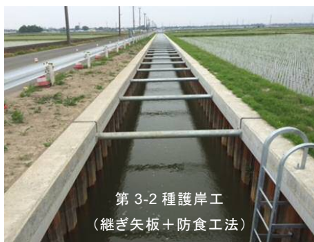
図-5 継ぎ矢板施工後の状況
