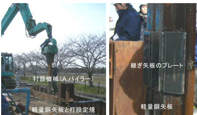
図-2 継ぎ矢板工法の概要
