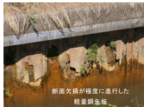
(4) 鋼矢板の腐食実態
